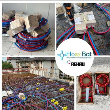
Système préfabriqué de gaines et de tubes sertis pour la plomberie et le chauffage, optimisant l'installation sur chantier et représentant une avancée significative dans le domaine de la construction.
